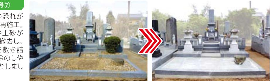
**リフォーム実例⑦** 墓所が傾き倒壊の恐れがあるため、基礎から再施工。また左右の植栽や土砂が付着した玉砂利を撤去し、墓所全面に板石を敷き詰めることで、お掃除のしやすい墓所を追求いたしました。
