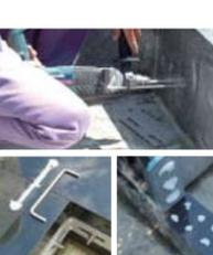
外柵(お墓の囲い)の石材は、接合部分すべてに専用ボンドを使用します。また、ステンレス製の耐震金具を用い二重に補強することで抜群の耐震強度をつくります。
