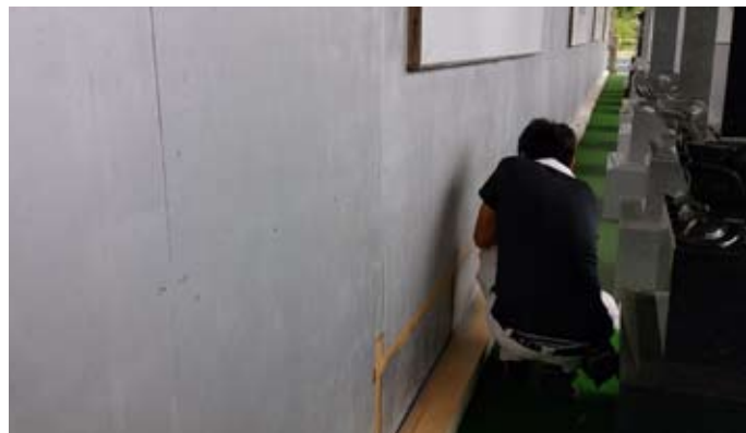
修復作業の様子
